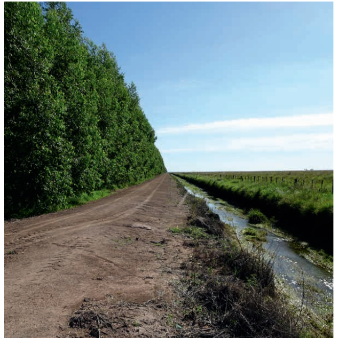
Ein gut angelegter Graben für die Entwässerung einer Eukalyptus-Anpflanzung.
